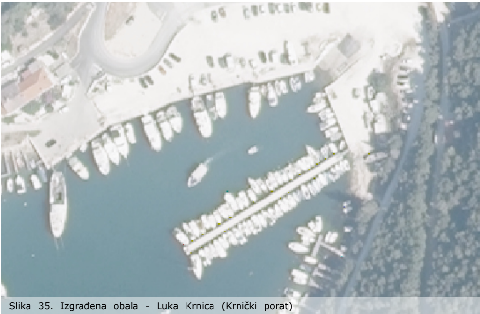
Slika 35. Izgrađena obala - Luka Krnica (Krnečki porat)
